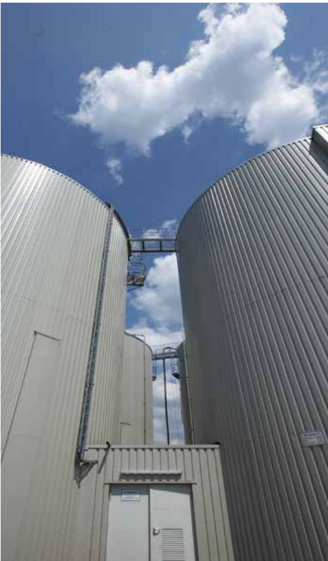
Biologische Anlage im EZS: In diesen Fermentern entsteht Biogas, das zur Strom- und Wärmegewinnung genutzt wird.
